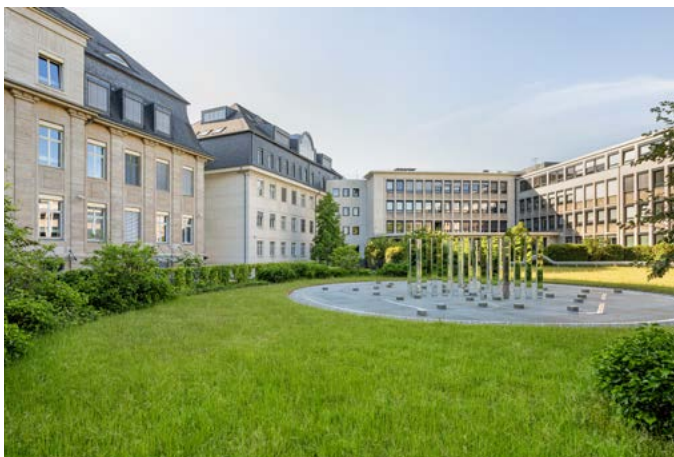
Das Büroensemble „Oppenheimstraße“ in Köln besteht aus vier Gebäudeteilen und ist nahezu voll vermietet.
